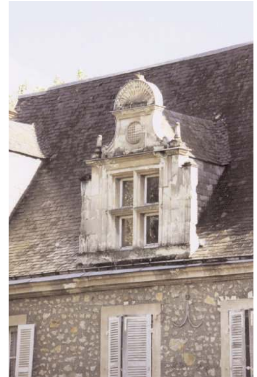
Lucarne Renaissance avec meneau et traverse. Les ouvertures étaient à l'origine fermées par des verres de petites dimensions, assemblés au moyen de plomb (vitreaux mis en plomb).
