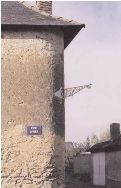
Potence pour d'anciennes lampes à huile permettant l'éclairage de la rue
