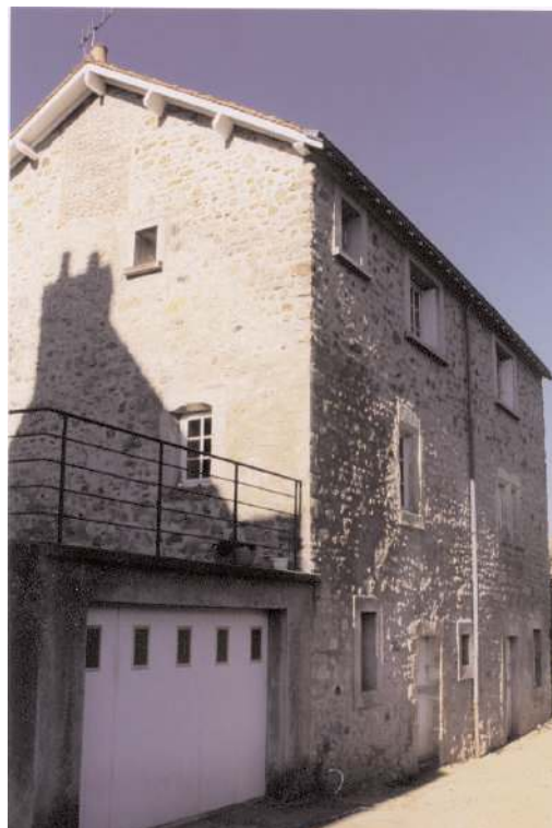
Maison du XV ème siècle, dont la volumétrie est très modifiée par la création d'un étage. La trace de l'ancienne toiture est visible sur le pignon.
