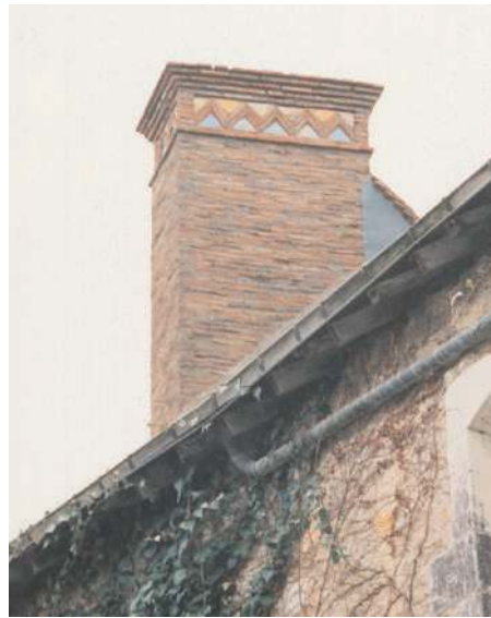
Souche de cheminée à carreaux de faïence.
