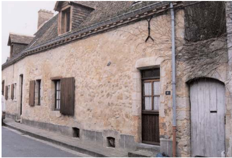
Maison basse XVIIème, avec corniche en brique formant des modillons à la manière de l'architecture classique .
