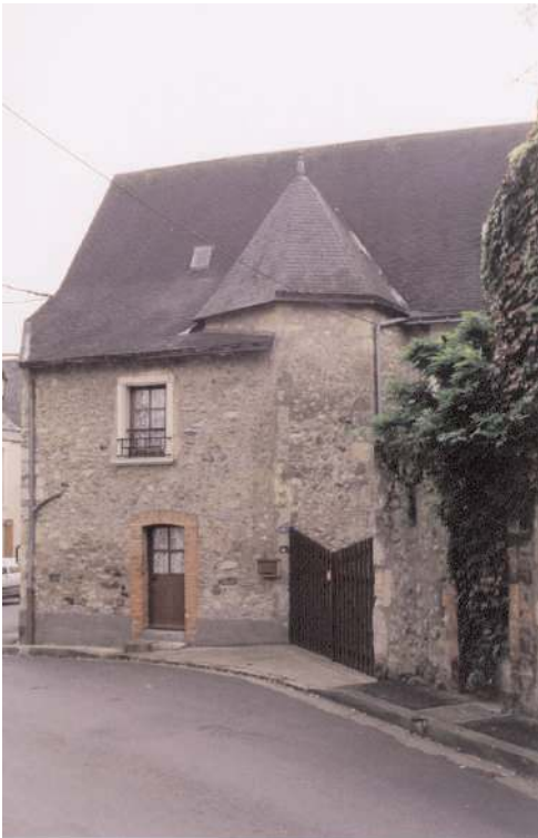
Logis XVIème, avec escalier en vis dans une tour hexagonale, modifié par une extension postérieure.
